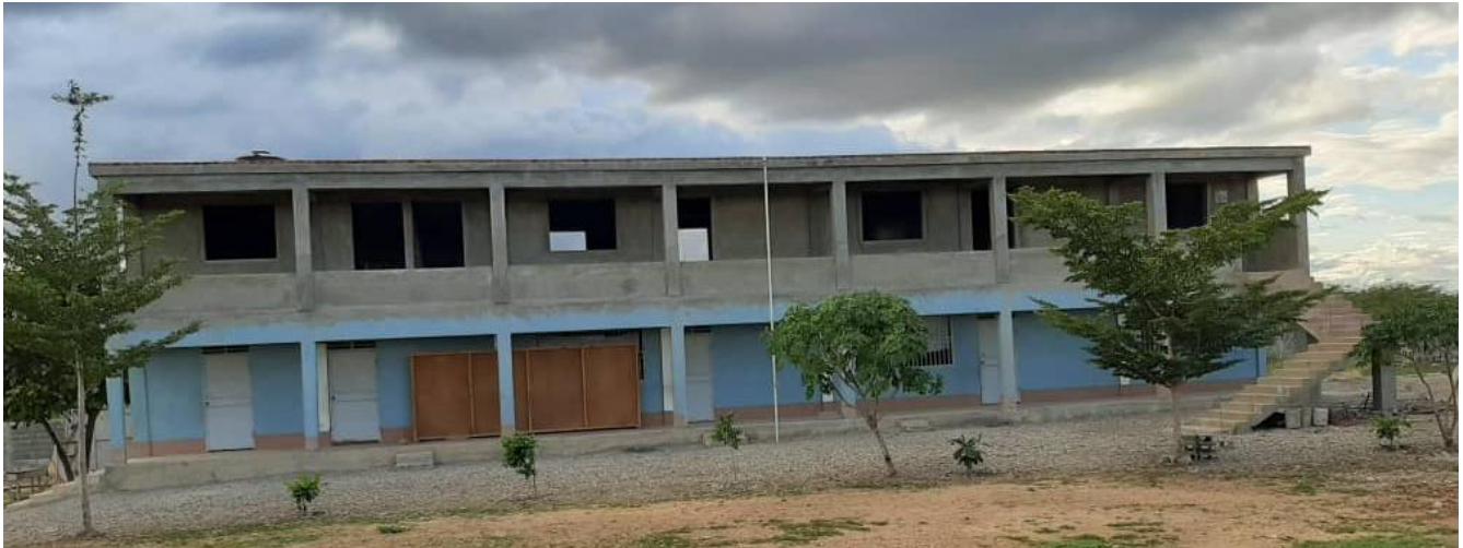
La nouvelle école en construction à la ferme de Fort Liberté.
